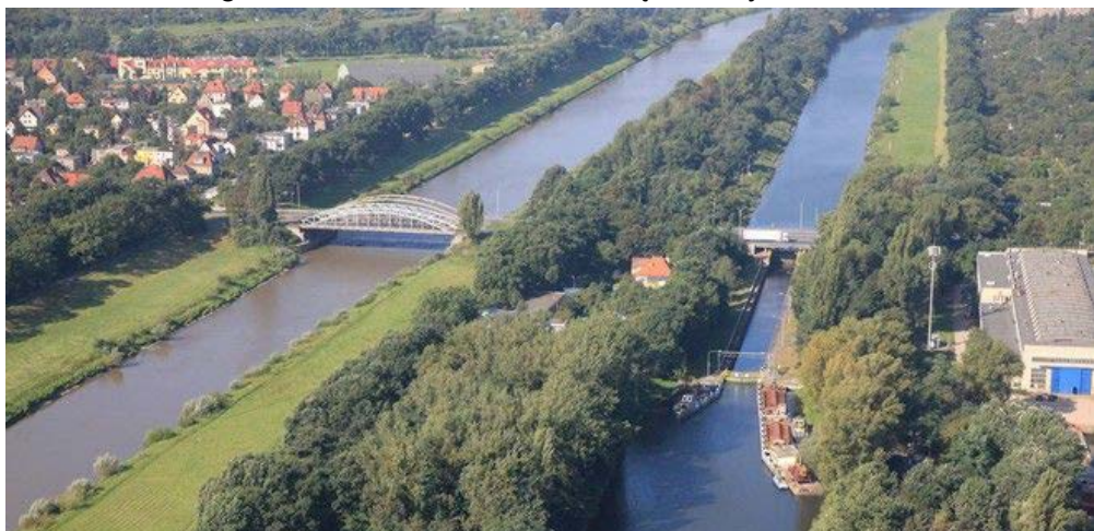
Mosty Jagiellońskie – po lewej nad kanałem powodziowym, po prawej nad kanałem żeglugowym – widoczna śluza Zacisze
