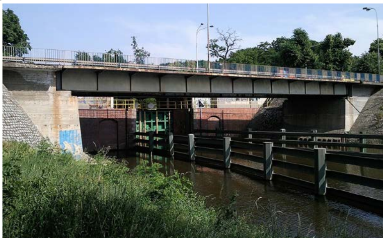
Powojenne przęsło północne, stare przęsło (i wrota śluzy) widoczne w tle
