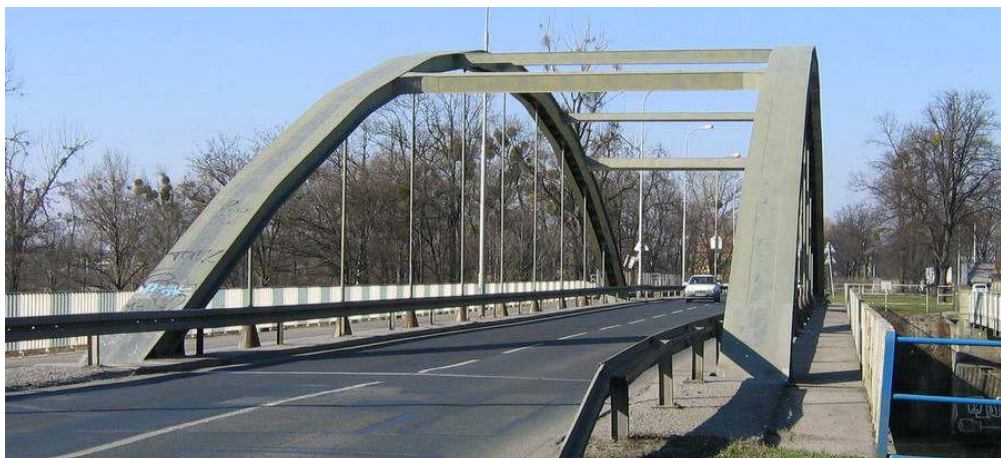
Przęsło południowe Mostów Jagiellońskich wybudowane 40 lat po wojnie
