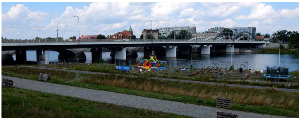
Mosty Warszawskie po przebudowie
