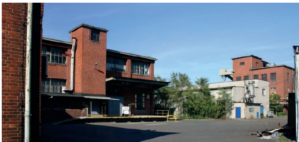
Część budynków fabryki przy Bierutowskiej zbudowali więźniowie. Przetrwali do dziś
