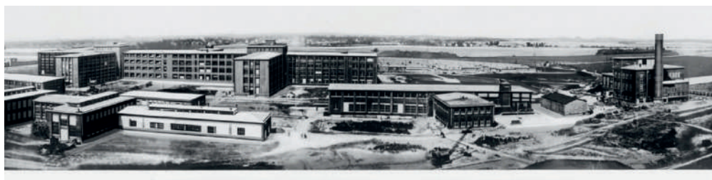
Zakłady Borsiga w trakcie budowy: lata 1940 - 1942
