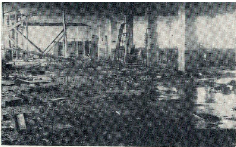
Zniszczona hala produkcyjna FASILU XXV lat WSK
