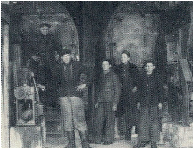
Obsada pierwszej kotłowni FASILU XXV lat WSK
